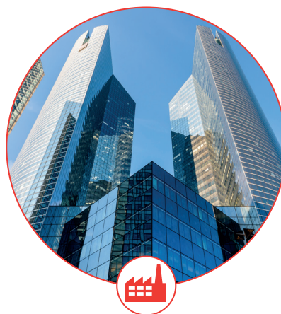
INDUSTRIE ET BÂTIMENT TERTIAIRE
