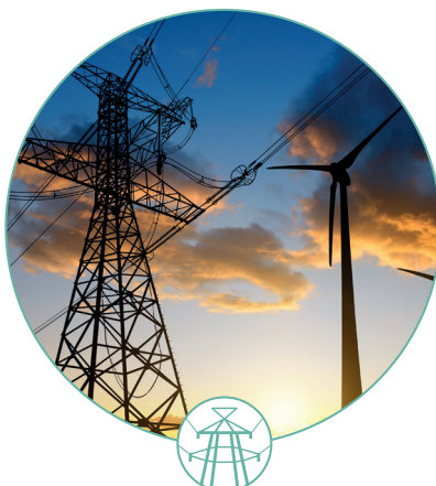
TRANSPORT ET DISTRIBUTION D'ÉNERGIE ÉLECTRIQUE
