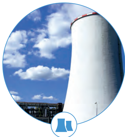
PRODUCTION D'ÉNERGIE ÉLECTRIQUE
