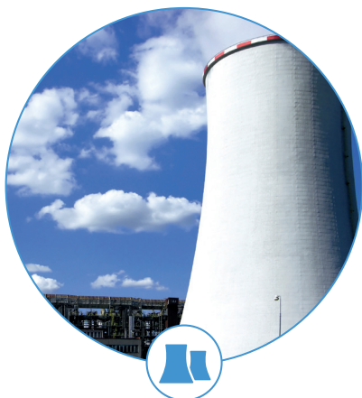
PRODUCTION D'ÉNERGIE ÉLECTRIQUE
