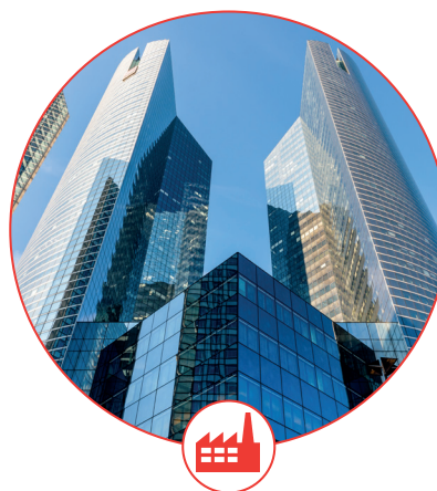
INDUSTRIE ET BÂTIMENT TERTIAIRE
