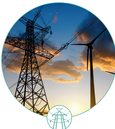
TRANSPORT ET DISTRIBUTION D'ÉNERGIE ÉLECTRIQUE
