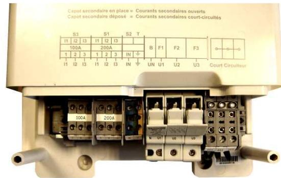
2 – Raccorder les câbles courant sur le calibre désiré (100A – 200A).
