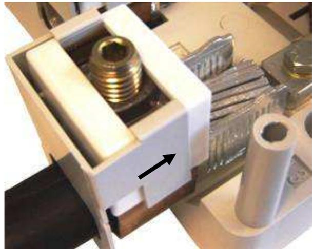
10 – Serrer légèrement la vis de l'étrier et vérifier la mise en place correcte du patin avant de serrer complètement la vis à l'aide d'une Clé mâle 6 pans de 6mm « Allen » (couple de serrage 45 N.m).
