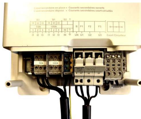
(\*) L'ouverture du bloc coupe circuit peut être réalisée à l'aide de la languette du capot secondaire par effet de levier.
