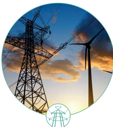
TRANSPORT ET DISTRIBUTION D'ÉNERGIE ÉLECTRIQUE
