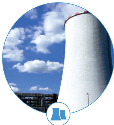
PRODUCTION D'ÉNERGIE ÉLECTRIQUE
