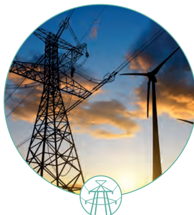
TRANSPORT ET DISTRIBUTION D'ÉNERGIE ÉLECTRIQUE
